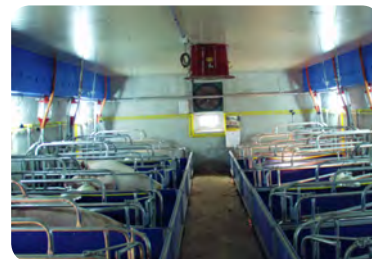
천장 단열재 처리
