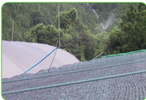
〈축사 지붕 위로의 물 분사〉
