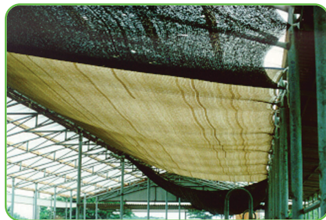
〈축사지붕 및 축사내에 차광망 설치〉
