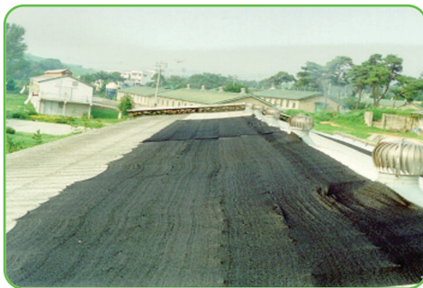
〈축사지붕 및 축사내에 차광망 설치〉
