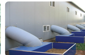
악취저감 장치 (개방형 바이오필터시스템)
