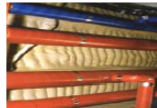
축사 내 단열재 설치
