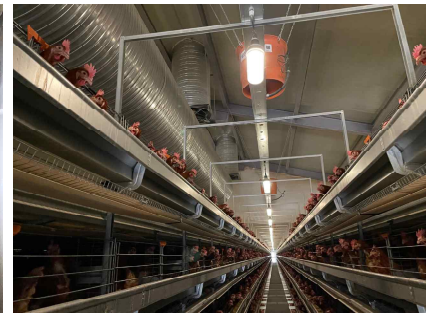
산란계사 지붕 아래 차벽 설치
